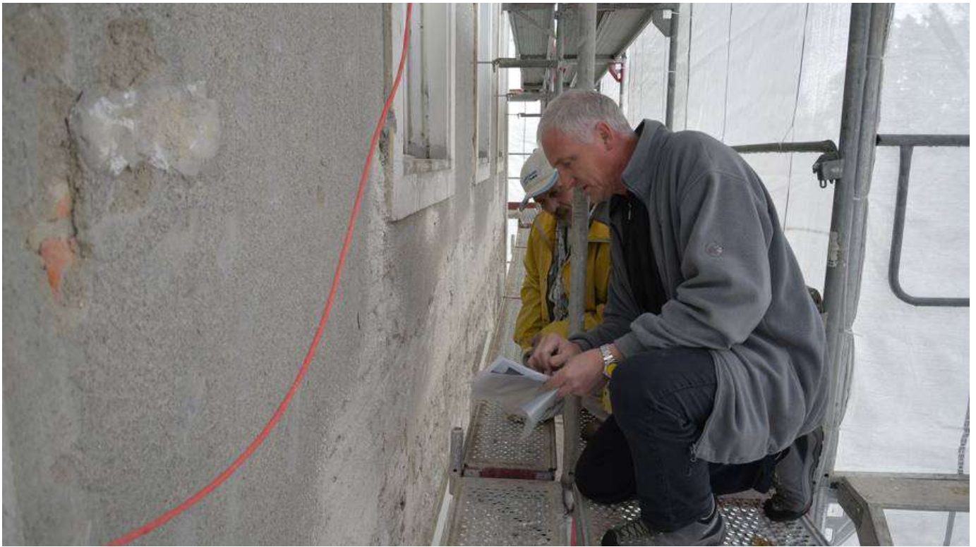
Enrico Sansoni bei der Sanierung des Gemeindehauses in Bettlach.
